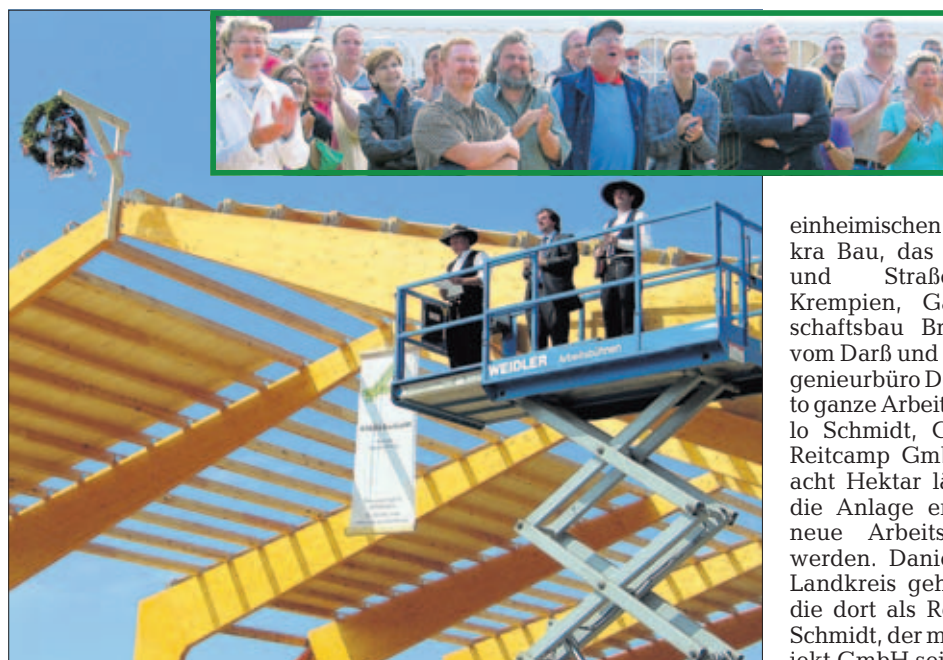
Applaus für den Börgerender Carlo Schmidt (M.) und die Zimmerleute, die den Richtspruch für die neue Reithalle verkündeten. Foto: Anett Jonuschat
